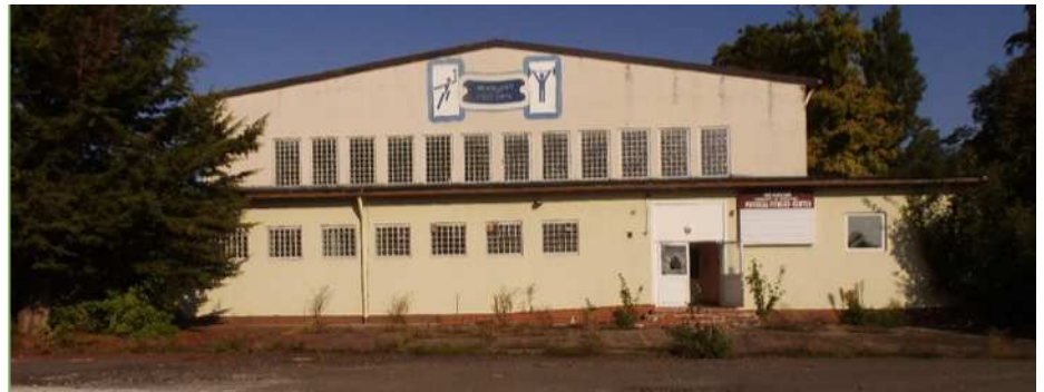
Sie soll saniert werden: Die Halle im Rhein-Selz-Park. Foto: Stadt
